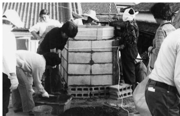
写真10 ブロックを使った焼却炉づくり （昭和50年代）
